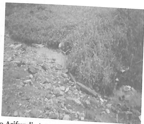
Atual rio Arifundi . A comunidade o está entulhando para a construção de moradias.
