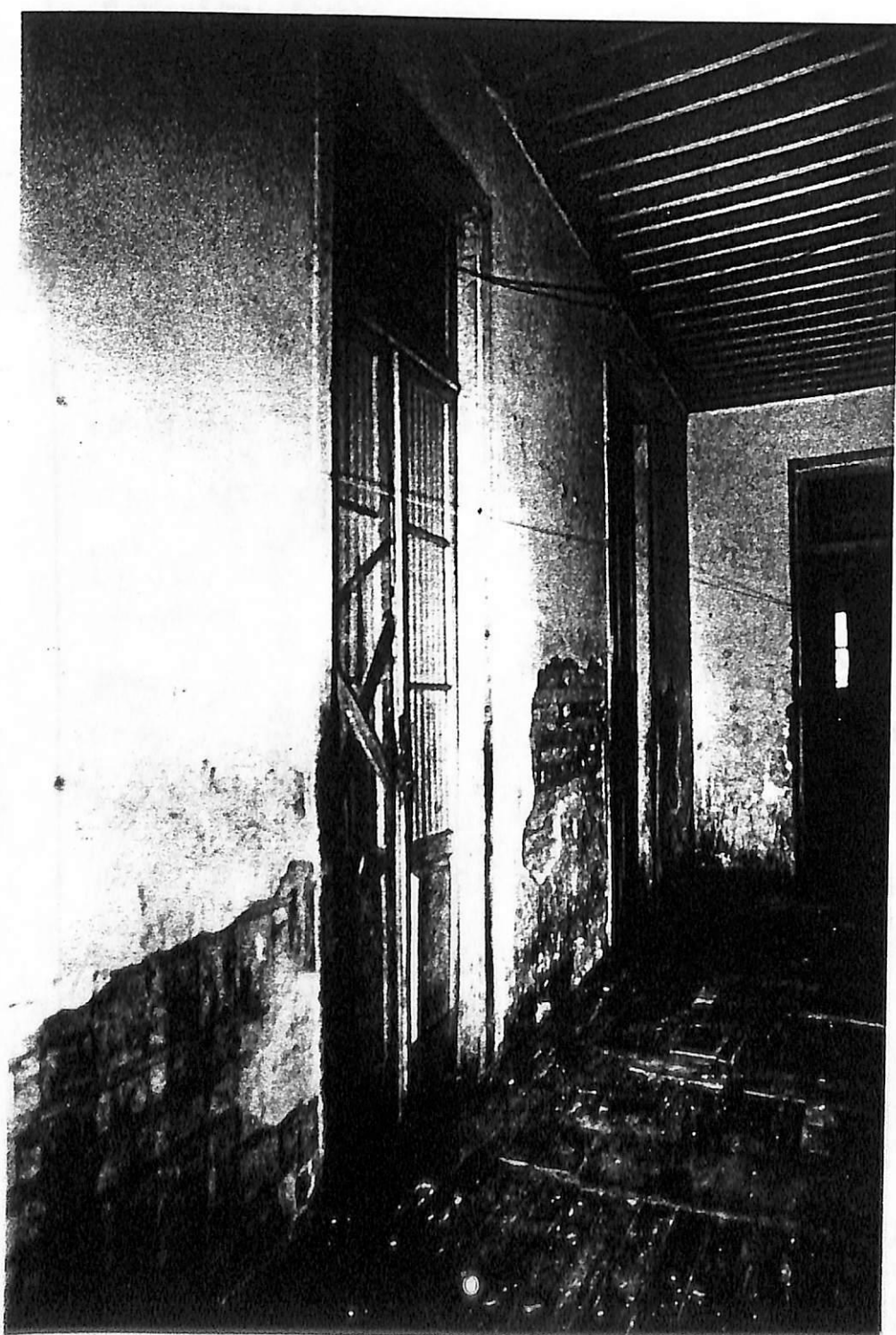
VISTA INTERNAS APRESENTANDO PAREDES DE ESTUQUE DESAGRE- GADAS PISOS E FORROS ESTRA- GADOS.
