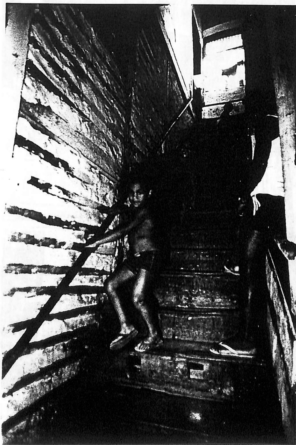
VISTA DO ACESSO, PRECÁRIO, COM PAREDE EM ESTADO DE DESAGREGAÇÃO.
