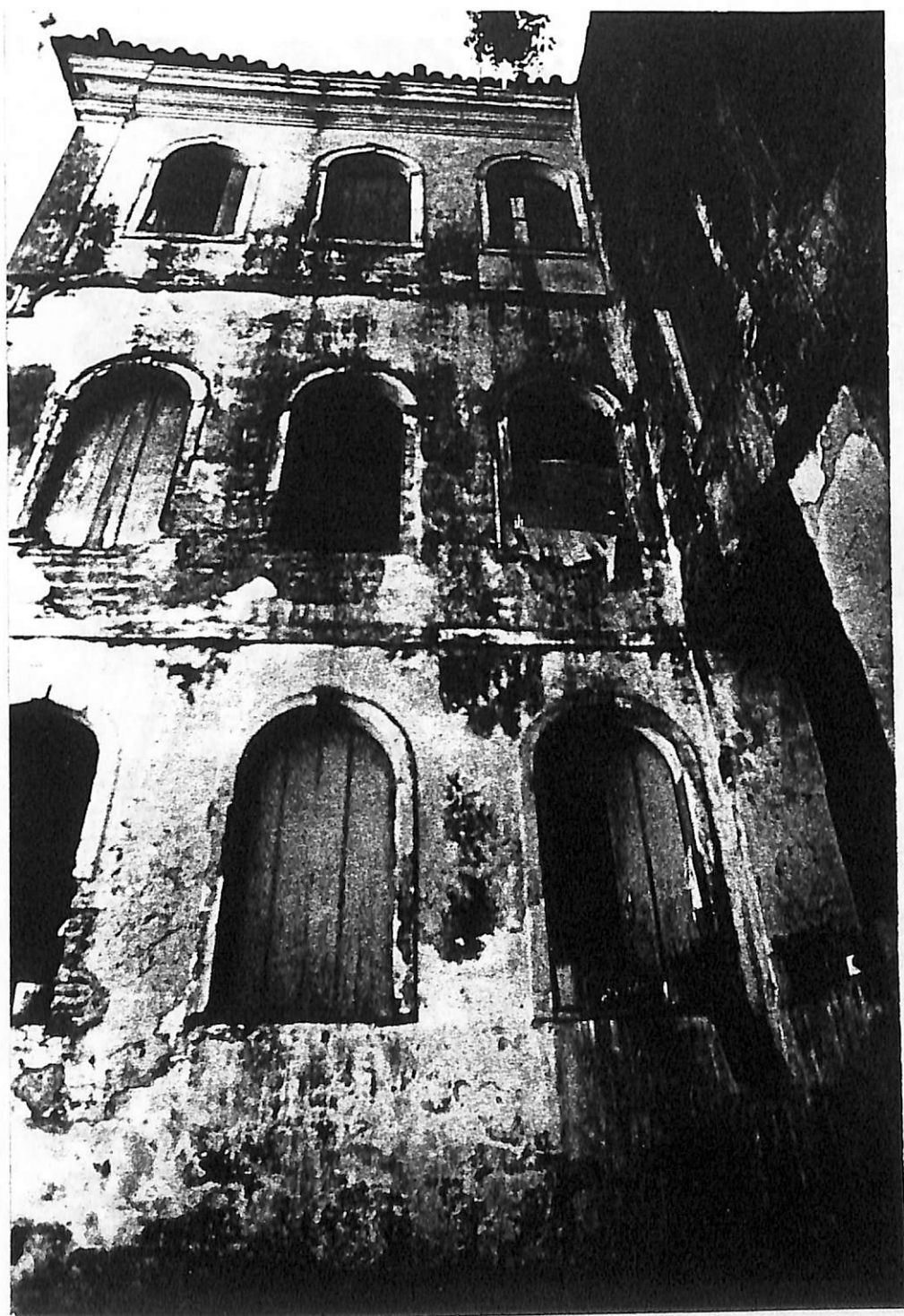
VISTA DA FACHADA DO FUNDO
