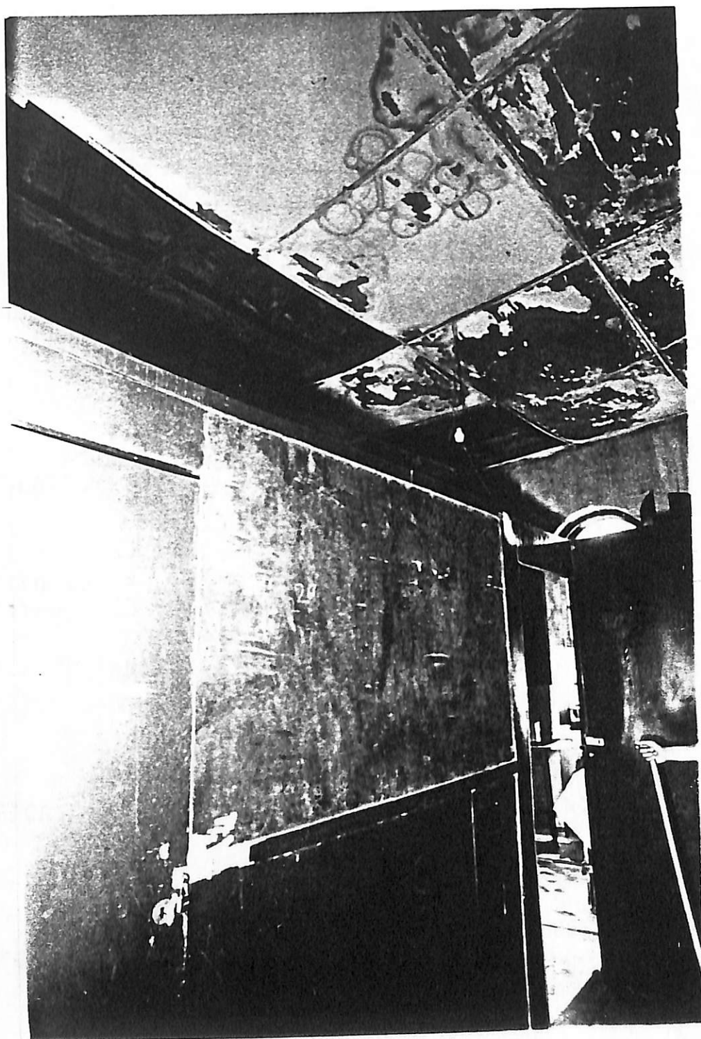
VISTA PARCIAL INTERNA DO IMÓVEL
