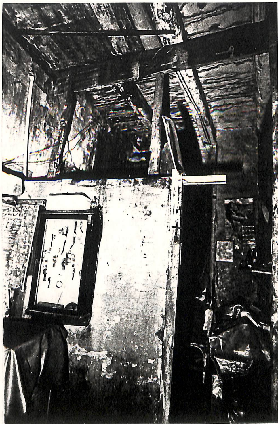
VISTA INTERNA APRESENTANDO BARROTEAMENTO ESCORADO.
