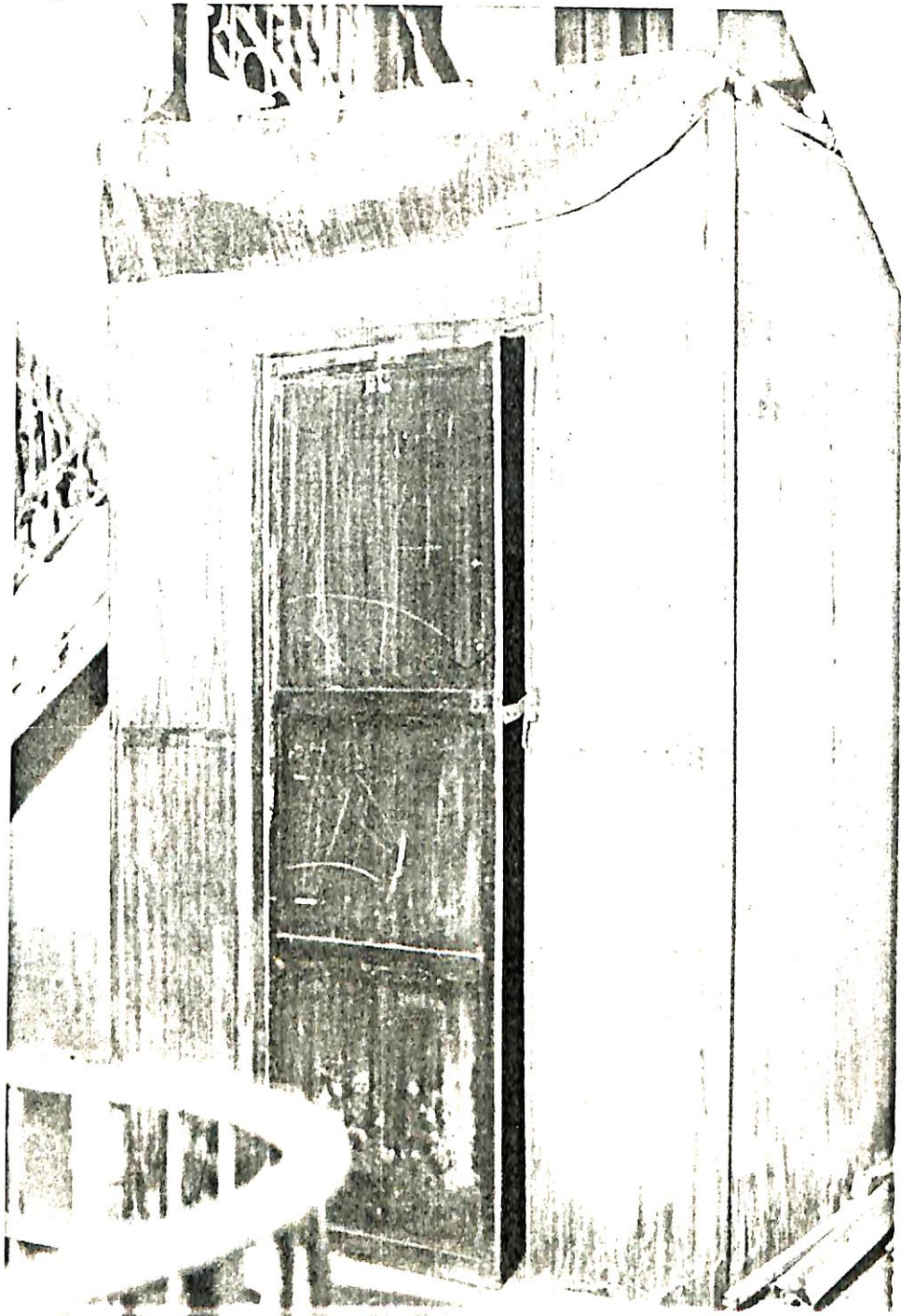
CAIXA DE MADEIRA DO ELEVADOR SITUADA NO MEZANINO, PARA PROTEGER O VÃO DE CIRCULA- ÇÃO VERTICAL.
