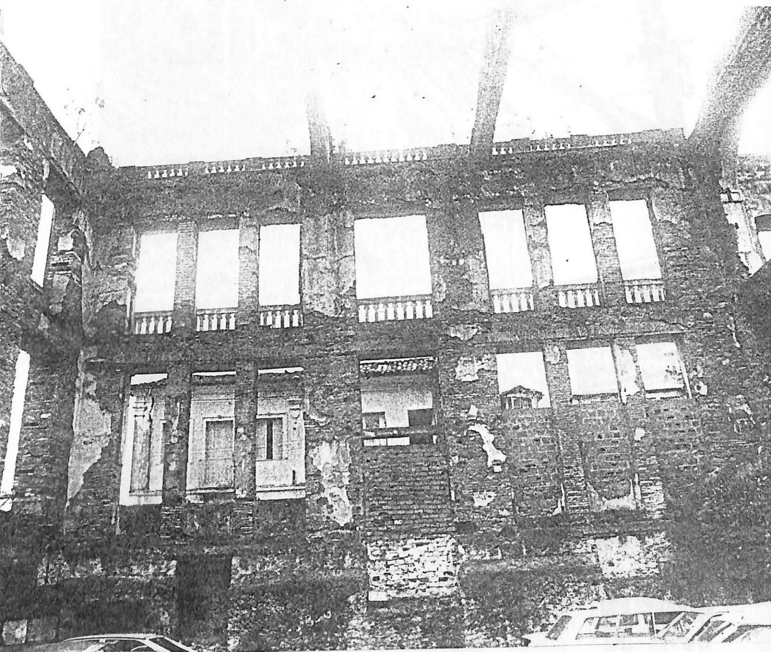
Área interna da antiga Rádio Excelsior (foto posterior ao incêndio)
