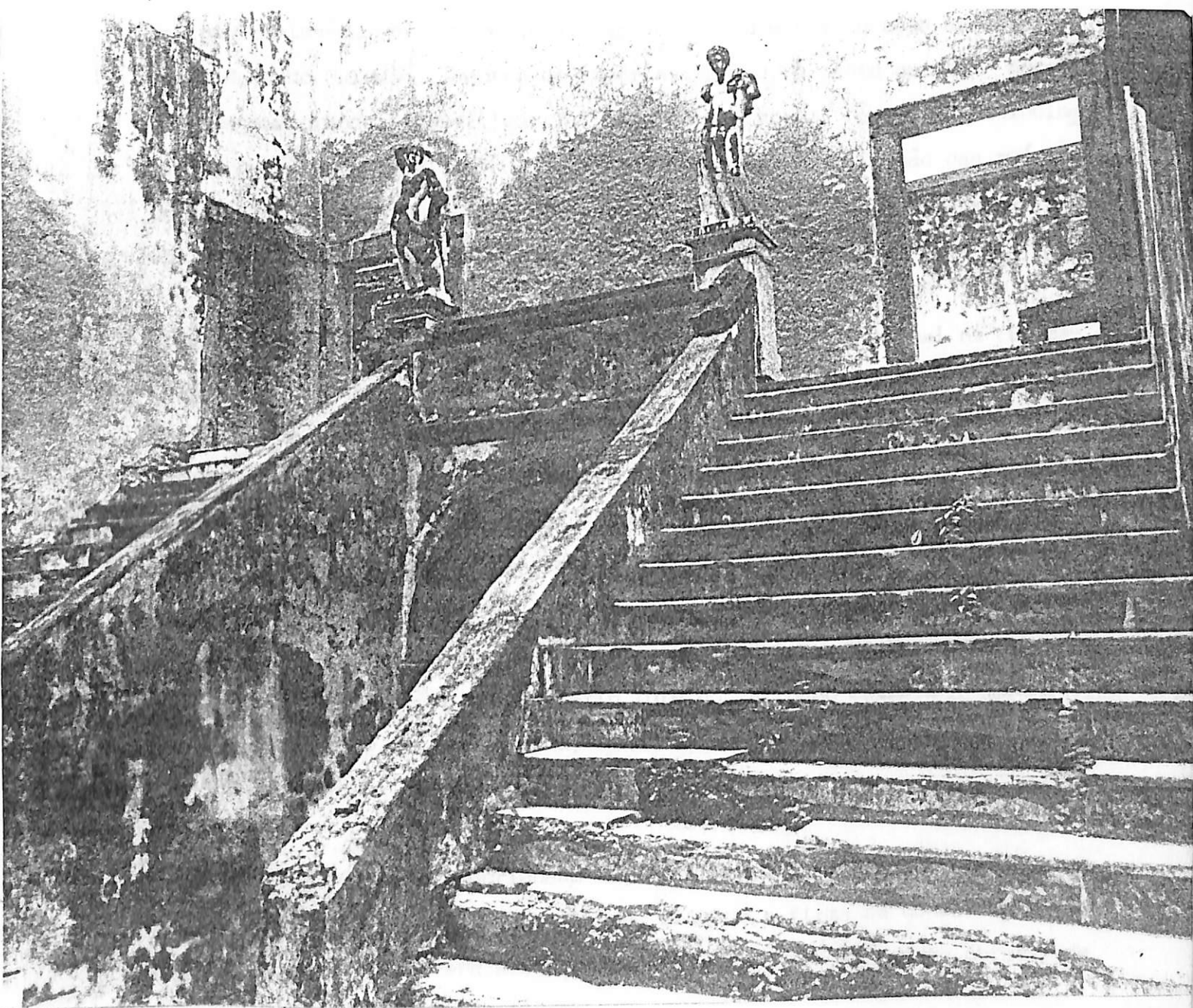
Escada principal Paço do Saldanha (foto posterior ao incêndio)
