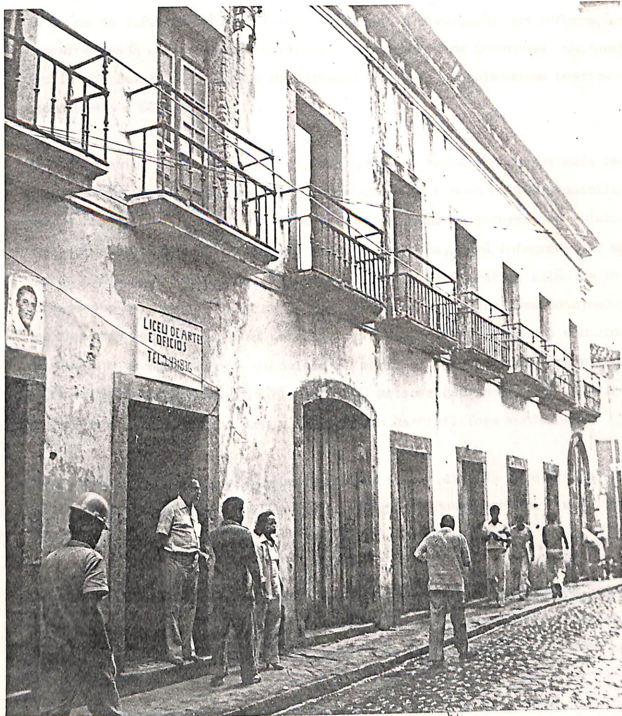
Paço do Saldanha - foto vista - rua Saldanha da Gama (foto posterior ao incêndio) (3)
