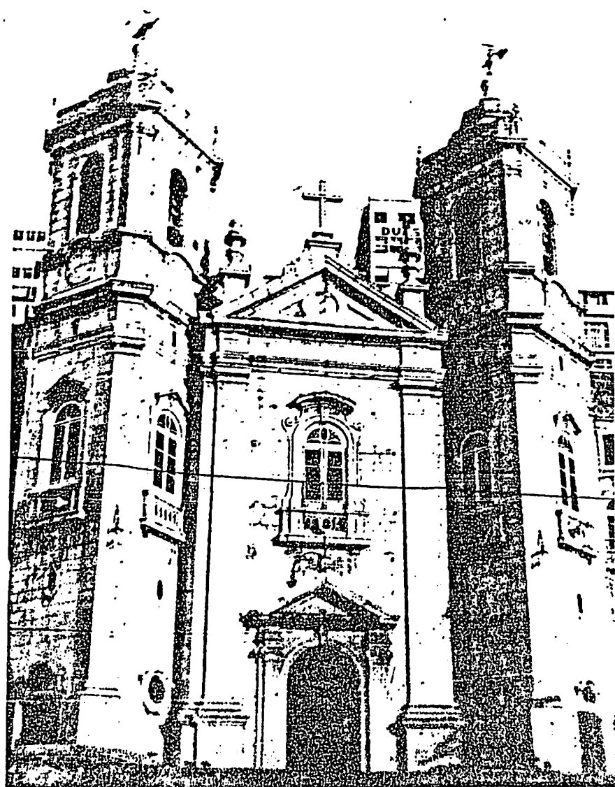
VISTA DA FACHADA DA IGREJA DE NOSSA SENHORA DA CONCEIÇÃO DA PRAIA (CIDADE BAIXA)
