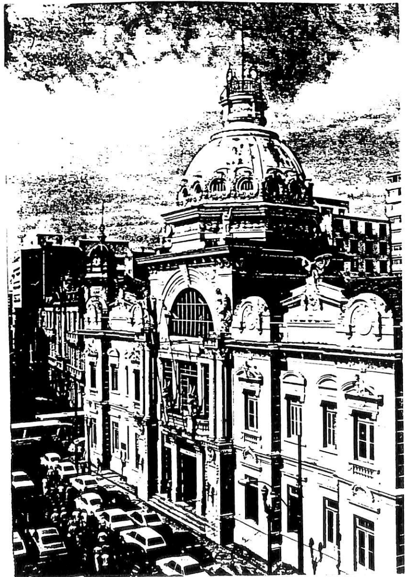
VISTA PARCIAL DO PALÁCIO RIO BRANCO
