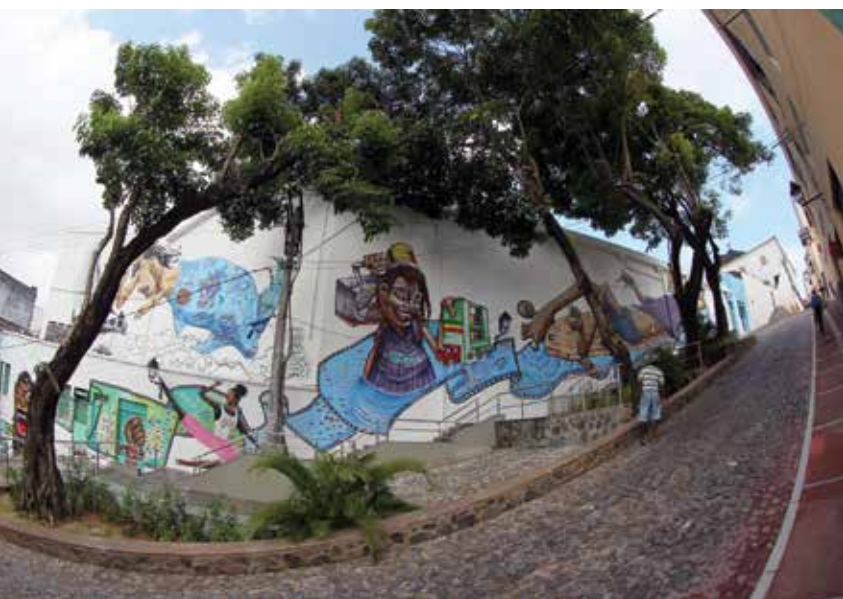
Requalificação Urbana da Ladeira da Ordem 3ª de São Francisco (Ladeira do PAX) - Fonte. Manu Dias Secom GOVBA
