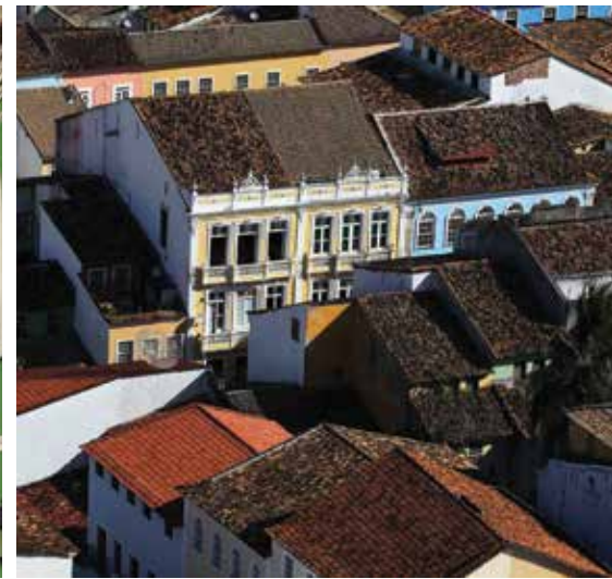
Vista dos telhados do casario, característica marcante do Centro Histórico - Fonte. Manu Dias Secom GOVBA
