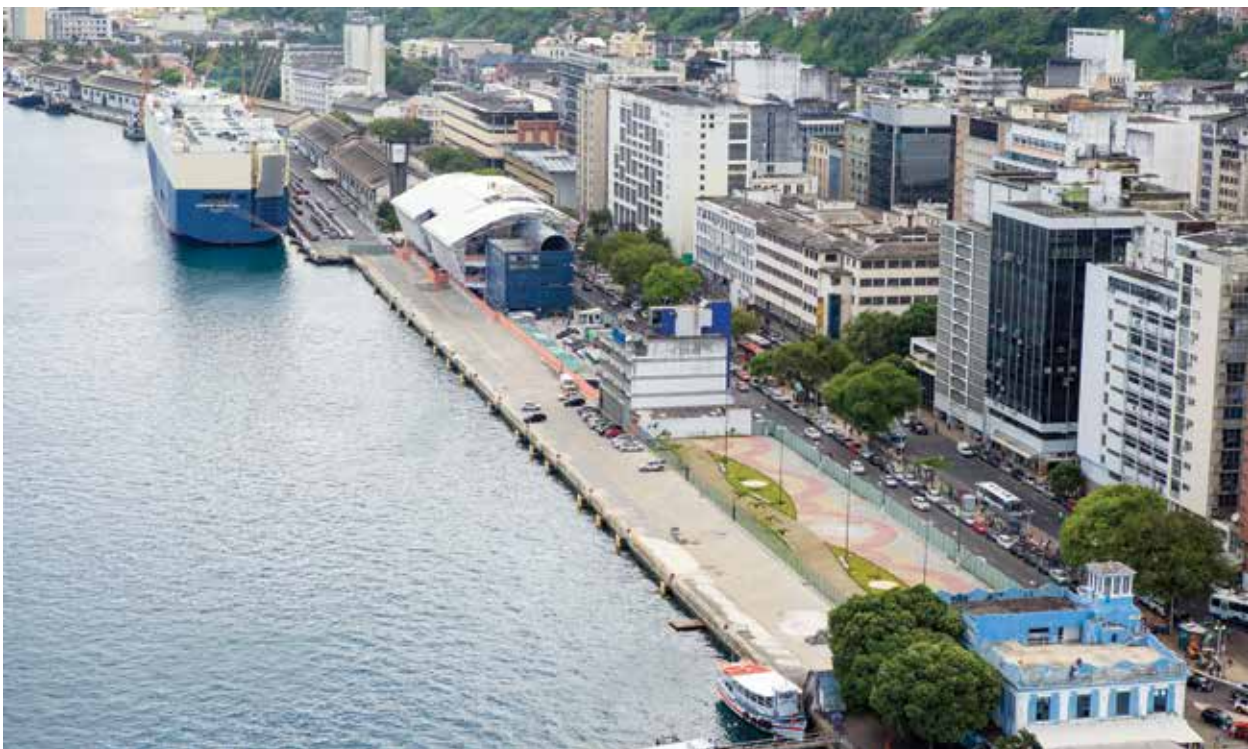
Obras do Terminal de Passageiros - Fonte. Galeria de Divulgação Programa de Aceleração para o Crescimento
