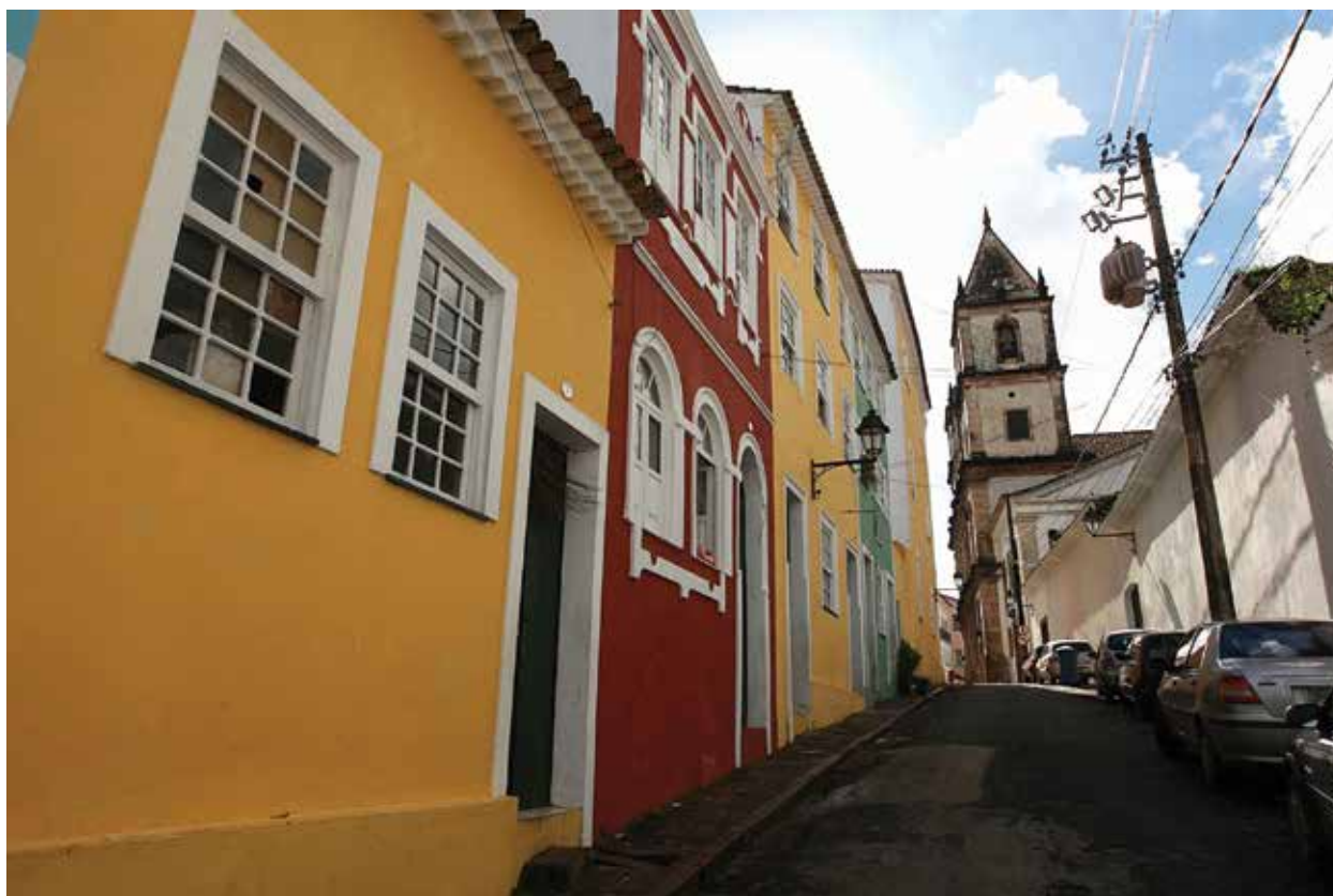
Unidades habitacionais entregues a servidores públicos no Centro Histórico - Fonte. Carla Ornelas Secom
