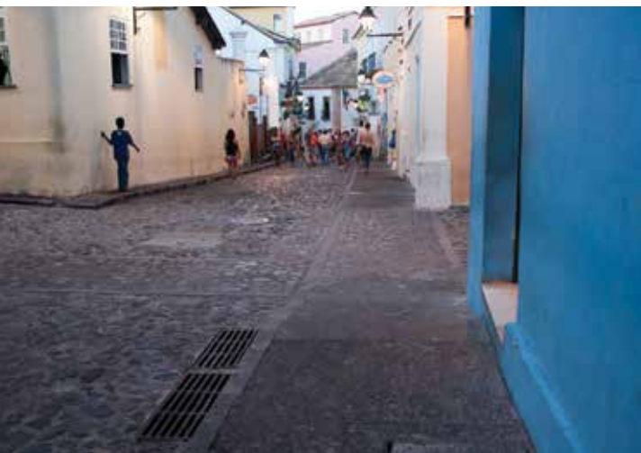
Calçadas acessíveis nas ruas do Pelourinho - Fonte. DIRCAS.CONDER
