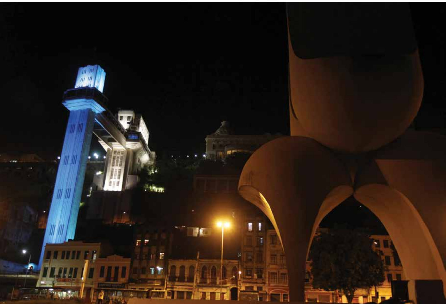
Elevador Lacerda - Símbolo de conexão entre Cidade Alta e Cidade Baixa - Fonte. Adenilson Nunes Secom GOVBA
