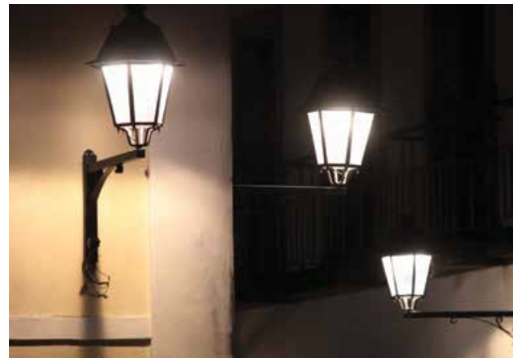
Iluminação pública nas ruas do Centro Histórico - Fonte: Adenilson Nunes Secom GOVBA
