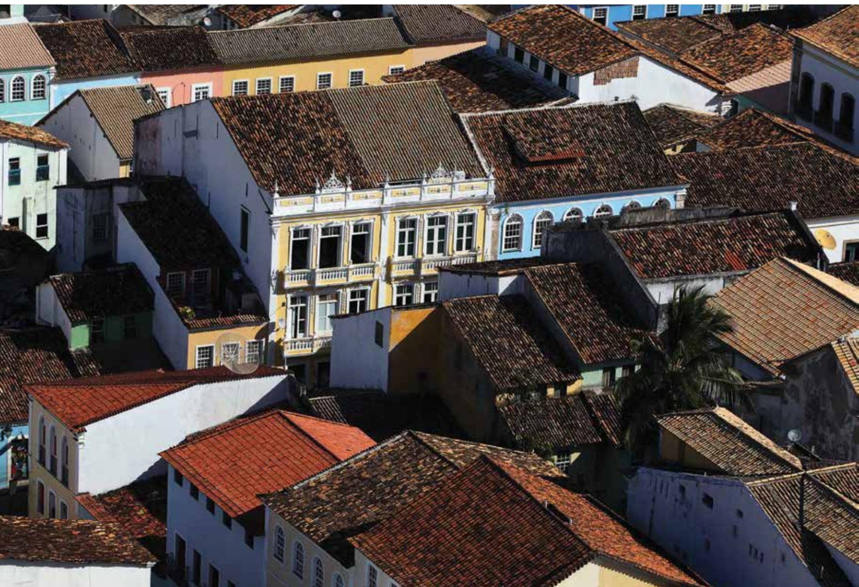
Vista dos telhados do casario, característica marcante do Centro Histórico - Fonte. Manu Dias Secom GOVBA
