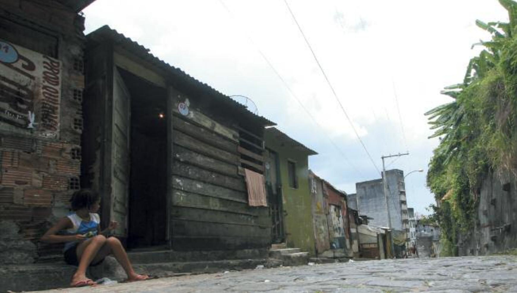
Foto 3 - Moradias insalubres no Pilar. Fonte: Ivan Erick/AGECOM.
