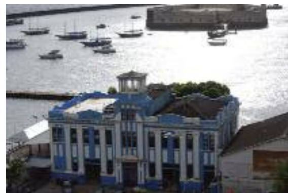
Terminal Marítimo Cais da Baiana. Fonte: Arquivo ERCAS.
