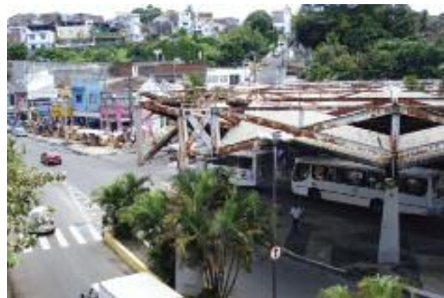
Terminal do Aquidabã. Fonte: Vaner Casaes/Agecom.
