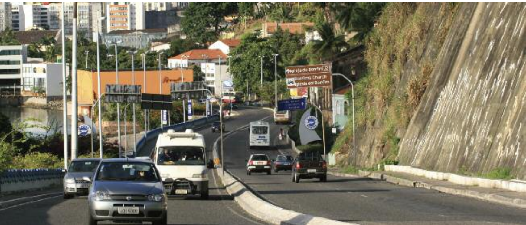
Avenida Lafayette Coutinho (Contorno). Fonte: Aristeu Chagas/Agecom.
