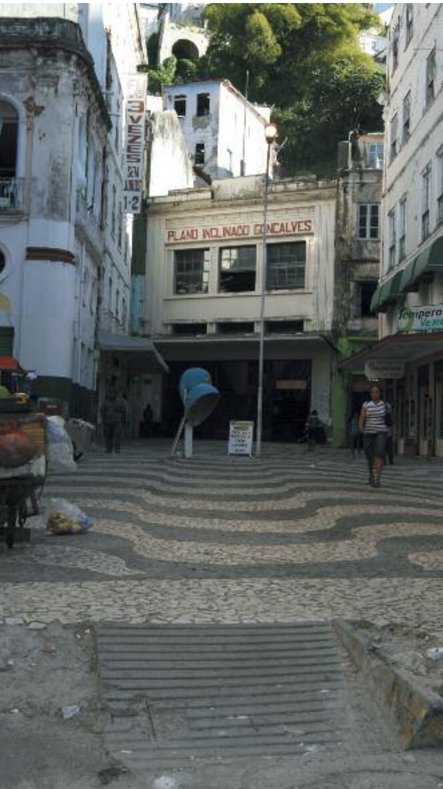
Foto 7 - Rampa de acessibilidade no Plano Inclinado Gonçalves no Comércio. Fonte: Arisson Marinho/AGECOM.
