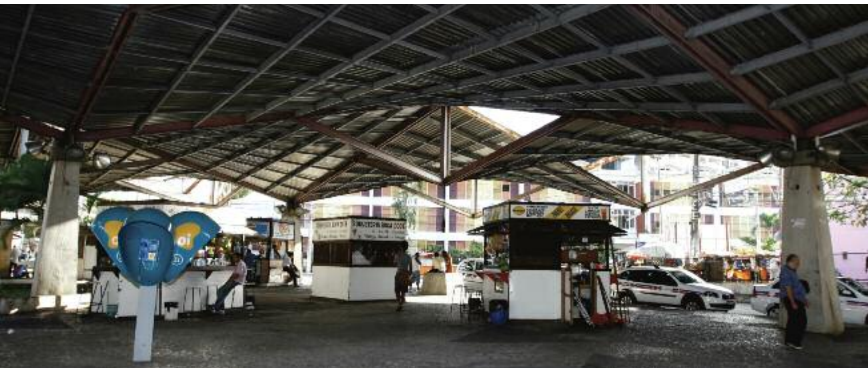
Terminal do Aquidabã. Fonte: Vaner Casaes/Agecom.
