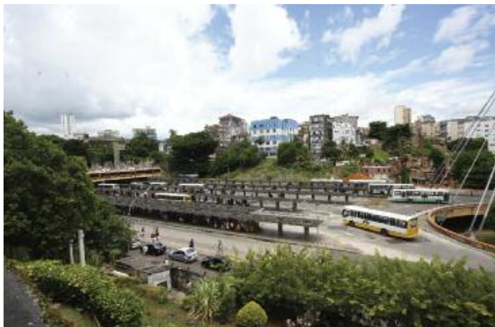
Terminal da Estação da Lapa. Fonte: Ivan Erick/Agecom.
