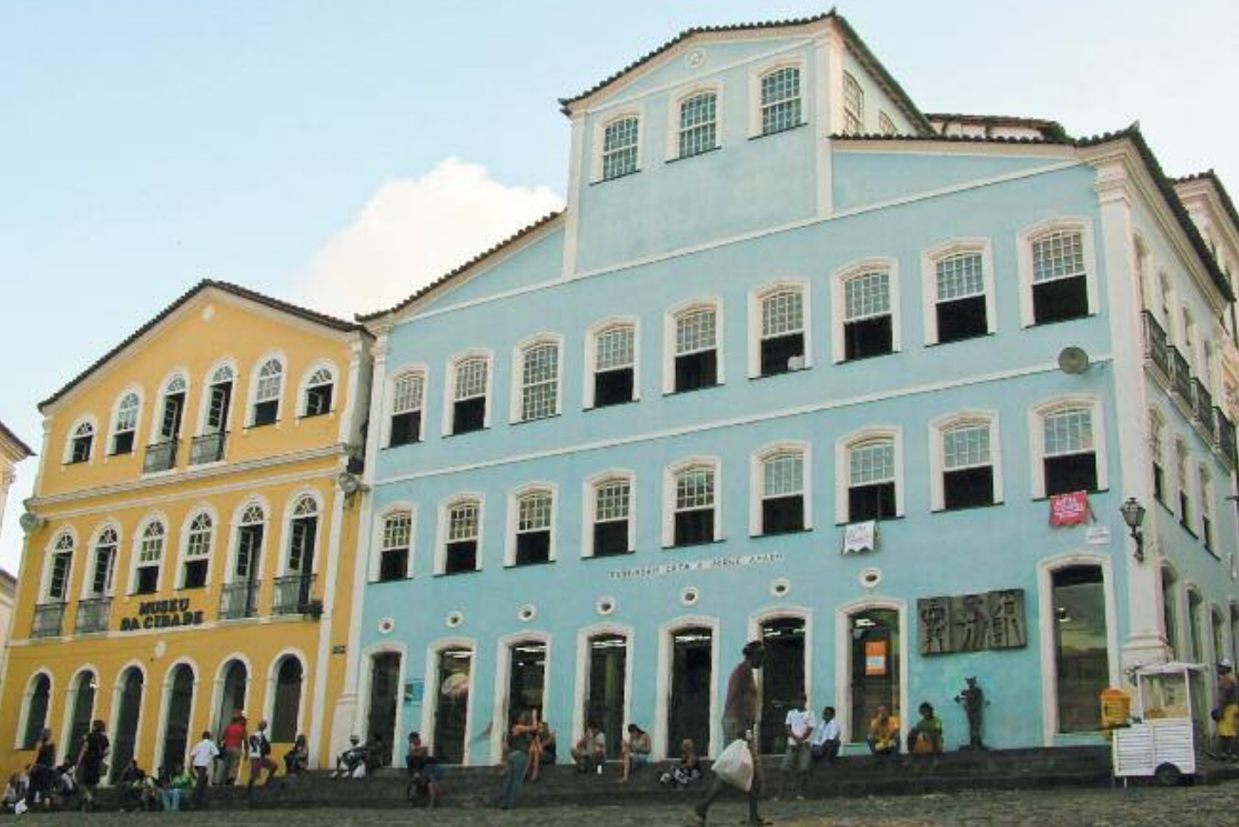
Foto 12 – Fundação Casa de Jorge Amado. Fonte: Arquivo ERCAS.
