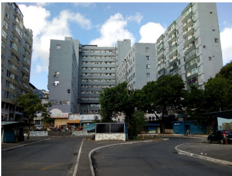
Entrada do Túnel Barroquinha / Estação da Lapa
