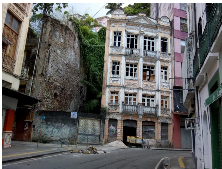
Saída do túnel na R. Guindaste dos Padres
