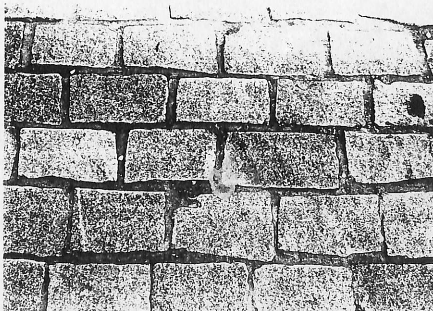
21. Detalhe do assentamento sem sujar a pedra.
