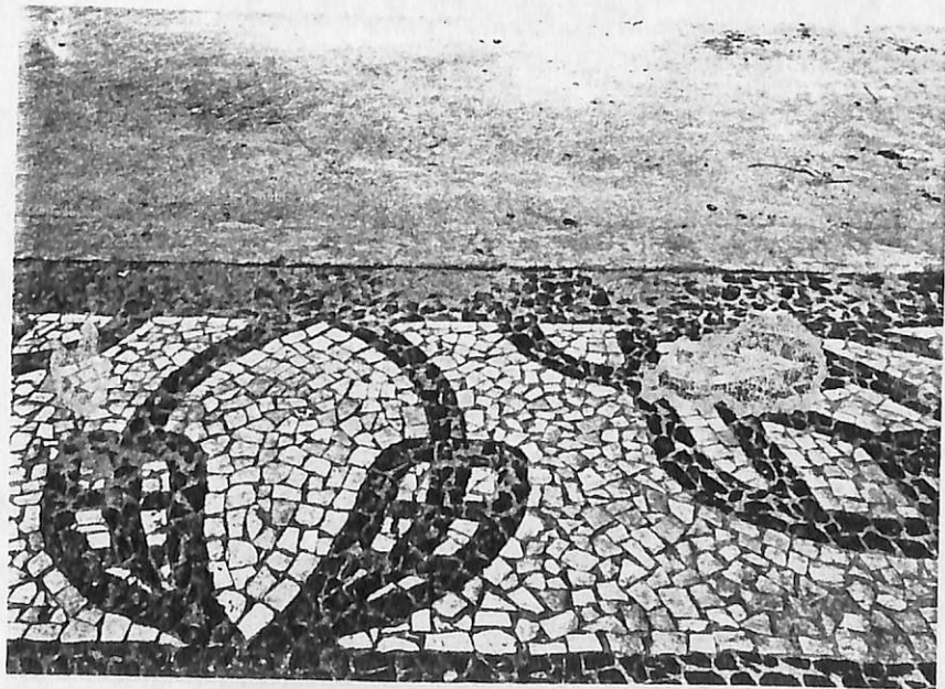
49. Detalhe encontro das duas pavimentações.
