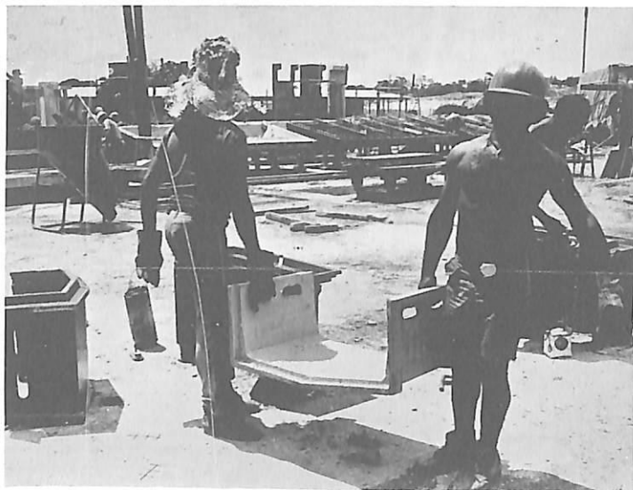
Peças Pré-Moldadas — galerias drenantes
