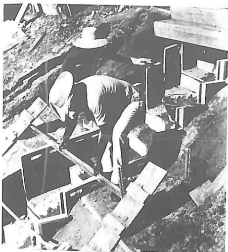
Via de Pedestres — trecho em construção
