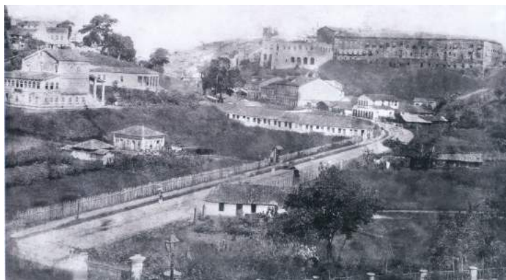
Fotografia de 1875, obtida da Ladeira do Arco, vendo-se a Avenida J.J. Seabra, onde existiam trilhos. O atual terminal do Aquidabã fica na parte inferior, à direita. O antigo Cine Tupy é visto no centro da foto. Ao fundo, está o Convento do Carmo.
