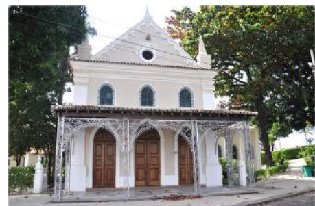
Igreja de Nossa Senhora das Vitórias - (Capela da Pupileira da Santa Casa da Misericórdia)
