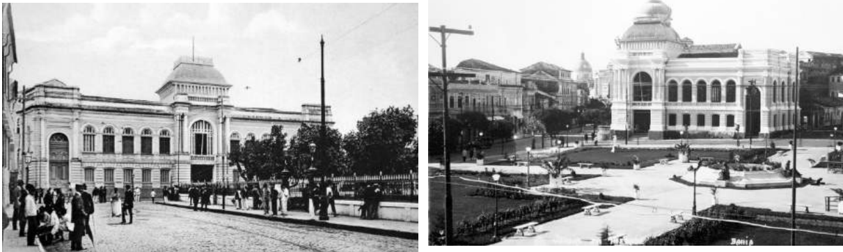
Edifício do Senado da Bahia antes e depois da demolição parcial
