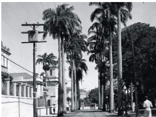
Jardim de Nazaré na década de 1940. A Igreja de Nazaré, à esquerda, já está com torres, que não existiam no início do século 20. http://www.salvador-antiga.com/nazare/nazare-antiga.htm
