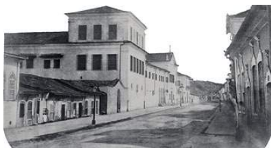
1862, com fachada anterior às demolições. Passeio Público ao fundo. Fotografia de Castro y Ordoñez
