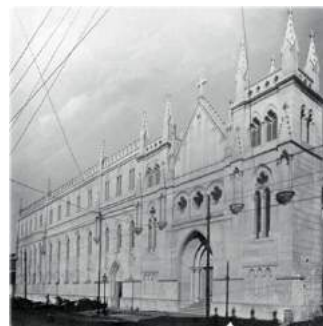
Fachada pós demolições
