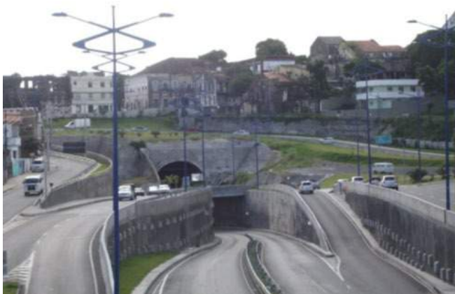
Túneis Via Expressa Portuária. Em destaque o Solar Bandeira
