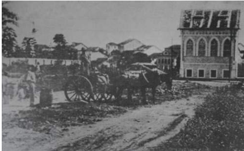
Demolição dos prédios no Campo da Pólvora no ano de 1935. Fonte: Arquivo Municipal
