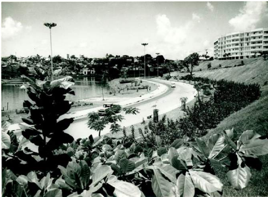
Vista do Dique com prédios que ocupam a via de contorno do Bairro Jardim Baiano no topo à esquerda
