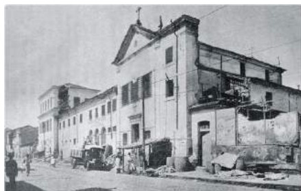
Processo de demolição em 1913. A fachada foi recuada de 3 a 4 metros para a passagem da Avenida 7
