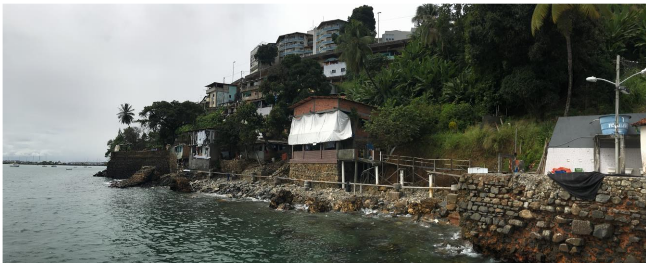
Fig. 17 Caixas de passagem expostas (centro) e caixa d'água coletora (a direita)
