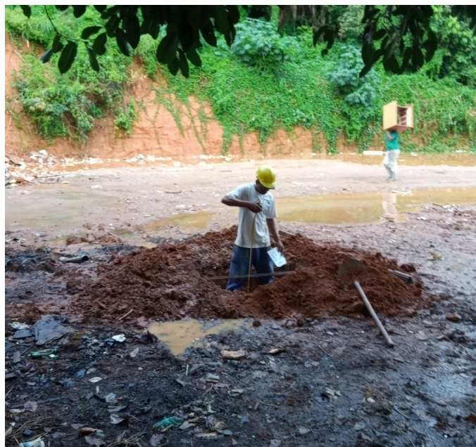
Foto 01 - Abertura de poço de coleta. ST-01.
