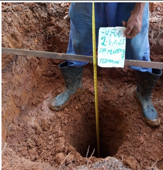
Foto 06 - Abertura de poço de coleta. ST-02
