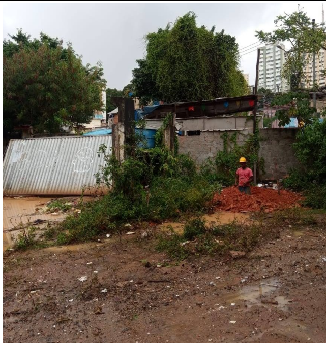
Foto 05 - Abertura de poço de coleta. ST-02
