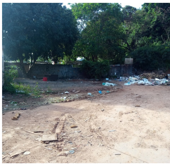
Foto 02 - Abertura de poço de coleta. ST-01
