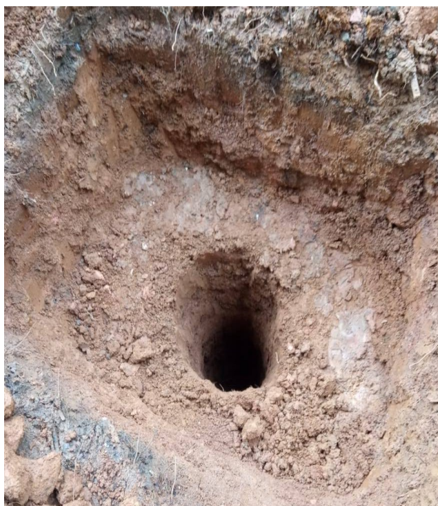
Foto 07 - Abertura de poço de coleta. ST-02
