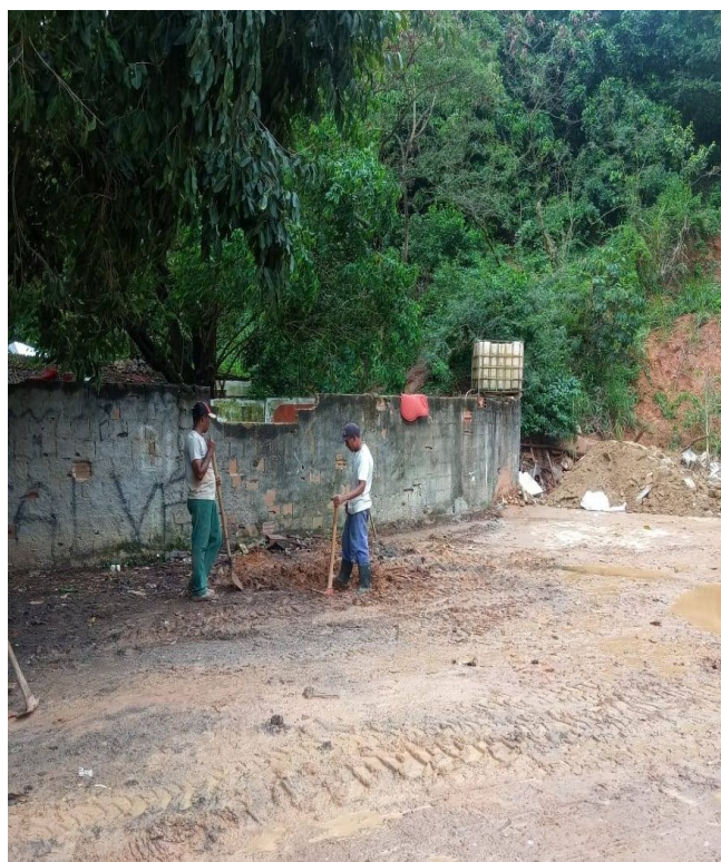
Foto 03 - Abertura de poço de coleta. ST-01
