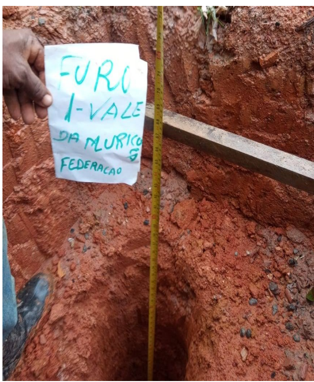
Foto 04 - Abertura de poço de coleta. ST-01
