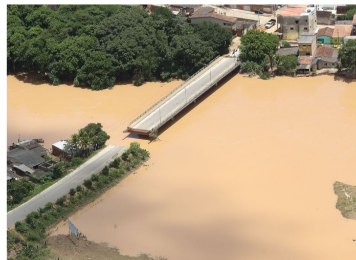
O MINISTÉRIO do Desenvolvimento Regional (MDR) já garantiu aproximadamente R$ 140 milhões ao estado para reparar danos das chuvas
