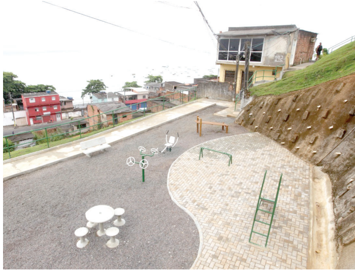
OBRA Mais de 3,5 mil moradores serão beneficiados
