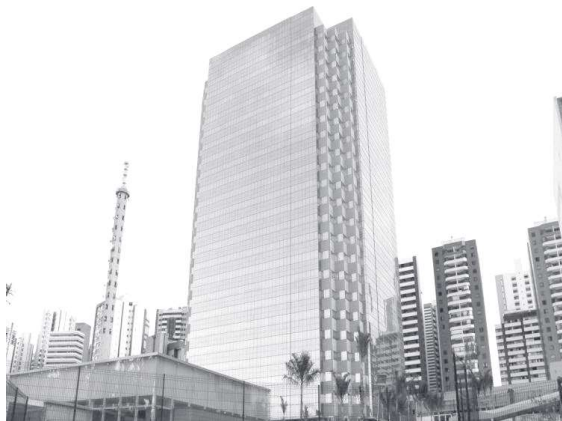
IMÓVEL Prédio está sendo desocupado. O procedimento integra o encerramento das operações
