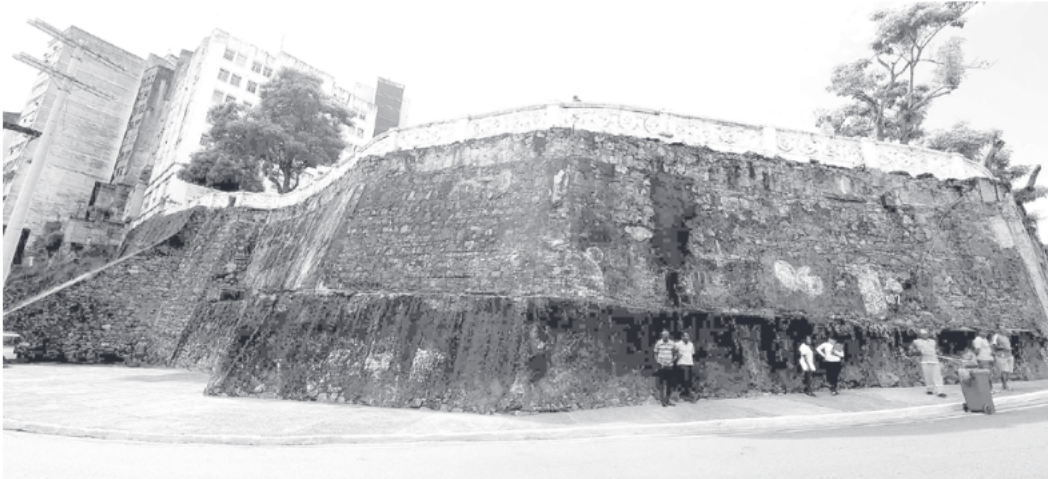
Fotos: Valter Pontes / Secom
