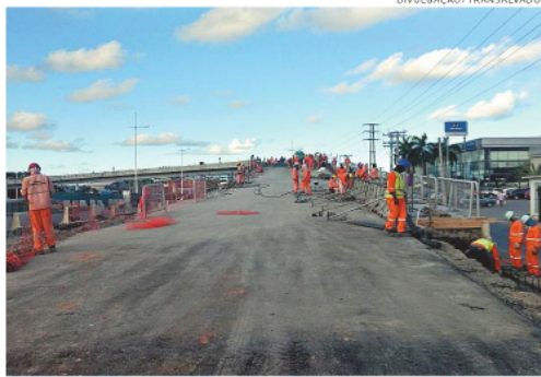
Obra já estão na fase final e viadutos serão liberados ainda este mês
