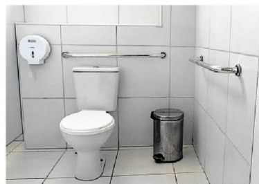
Reforços e barras de apoio agora podem ser exigidos
