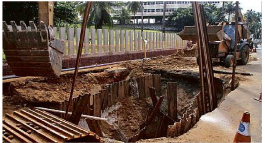
De acordo com a Secretaria Municipal de Manutenção, buraco se abriu por conta de problema na drenagem
