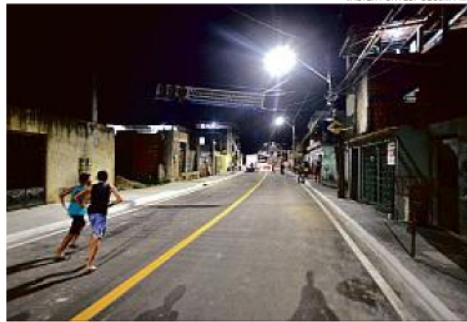
A Rua Castro Alves passou por drenagem e requalificação asfáltica
