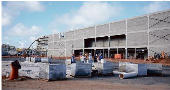
Obras na Boca do Rio estão 40% concluídas; equipamento deverá ser entregue até o final do ano
