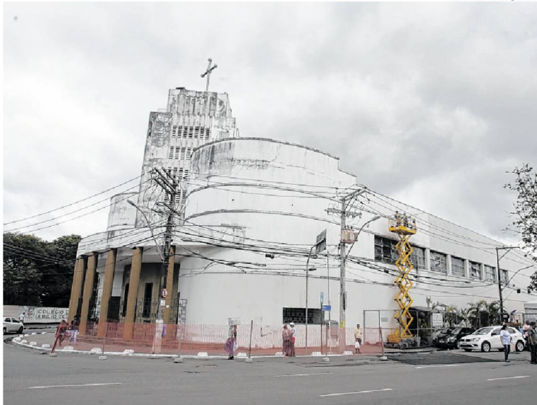
Pintura do prédio, reforma do velário, do batistério e troca do piso do interior do santuário estão entre as ações
