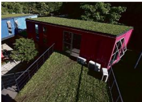
A utilização de energia solar e de cobertura vegetal diminui a temperatura dos ambientes controlando a necessidade de refrigeração artificial
