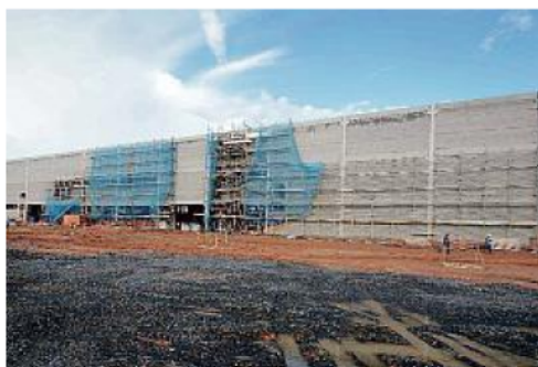
Parte da alvenaria do equipamento na orla da Boca do Rio está pronta
