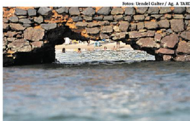
Buraco é visível na base do cais e aumenta com a ressaca
