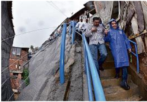
O prefeito inaugura a proteção, que é mais durável do que as lonas
