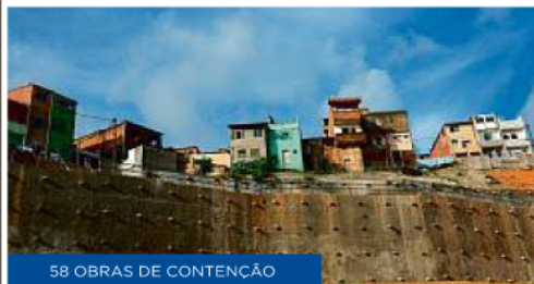
58 OBRAS DE CONTENÇÃO
