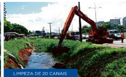
LIMPEZA DE 20 CANAIS
