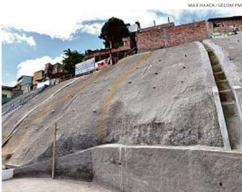
Obra de contenção custou R$ 1,7 milhão do Ministério da Integração
