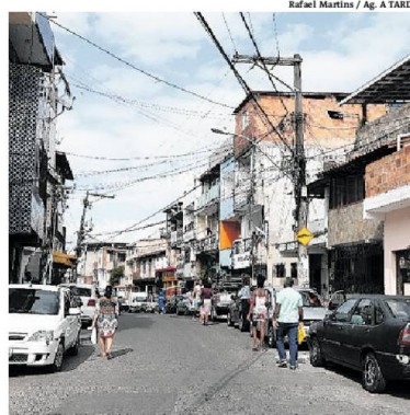
Obra na rua deve ser entregue em maio do próximo ano
