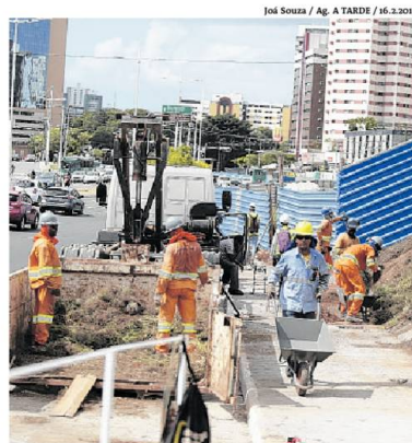
Prefeitura realiza obras do BRT na Av. ACM
