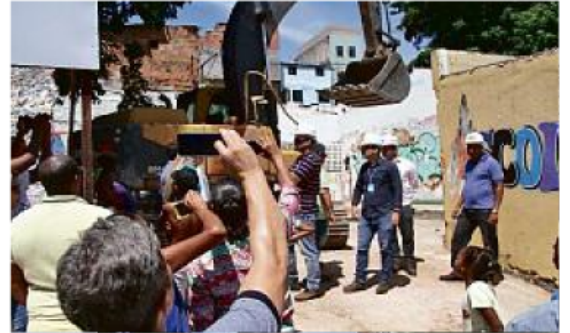
Moradores acompanham a demolição da antiga unidade infantil
