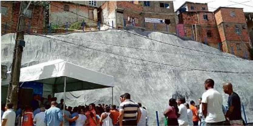
Mais de R$ 100 mil foram investidos nas obras da geomanta, que tem cerca de 650 m 2 de cobertura
