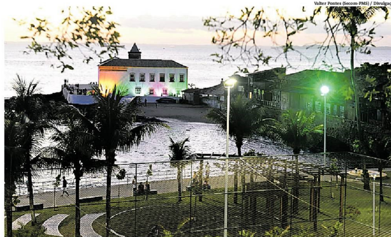
As obras envolveram recuperação da quadra, implantação de sanitários, área para capoeira e outras melhorias
