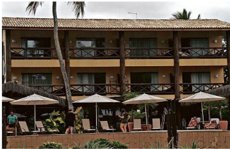
Hotel foi construído em dois lotes, mas ultrapassa área privada e invade espaço público e de preservação
