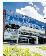
Hospital Couto Maia foi dotado de acessibilidade
