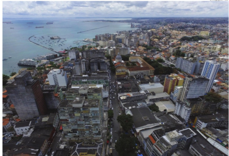
As obras da Prefeitura na Avenida Sete de Stembro terão duração de cerca de 14 meses
