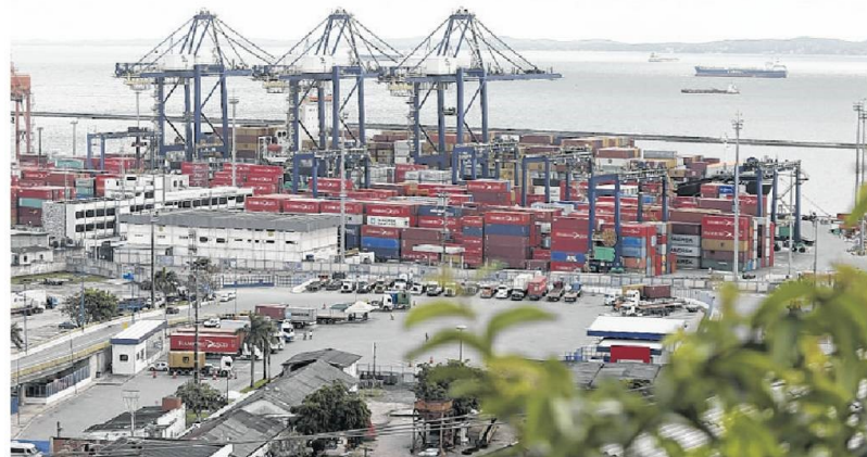
Terminal de Contêineres de Salvador estava tocando obras de ampliação de forma irregular, segundo Sedur
