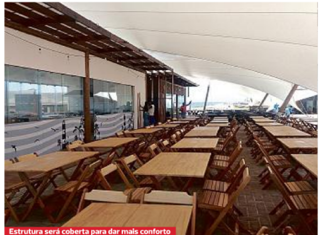
Estrutura será coberta para dar mais conforto
