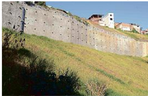
A intervenção ocupa 156 metros de extensão e 10m de altura
