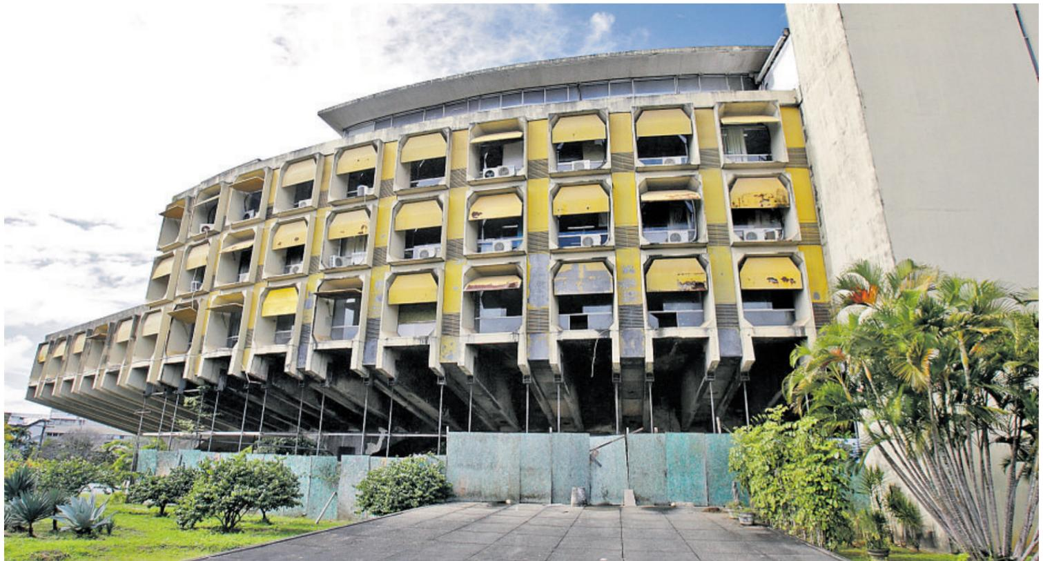
Tapumes foram colocados para isolar o imóvel atingido por incêndio. Base da estrutura está escorada por vigas metálicas de sustentação
