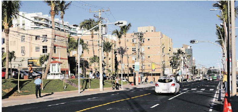
Pista foi liberada com asfalto novo e iluminação em led, em trecho de um quilômetro até o Rio Vermelho
