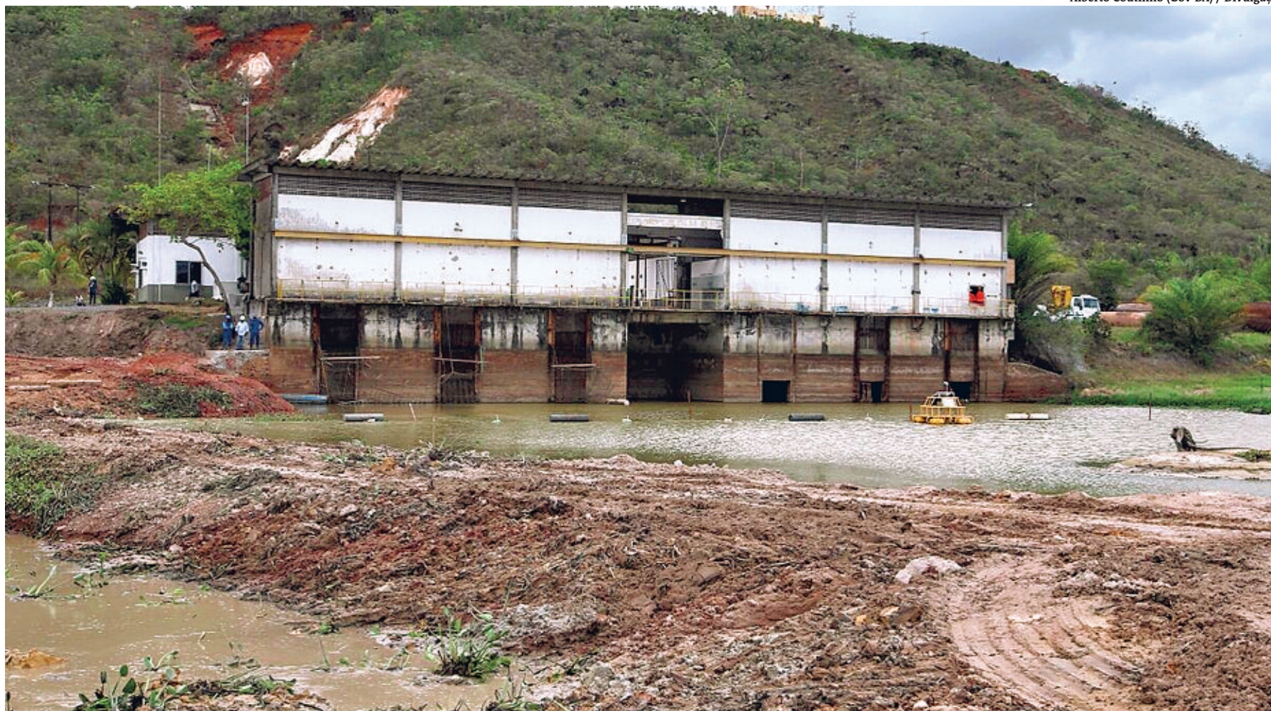
Ponto de captação da barragem de Santa Helena (Dias D'Ávila) apresenta situação bem abaixo do ideal, como em outros mananciais
