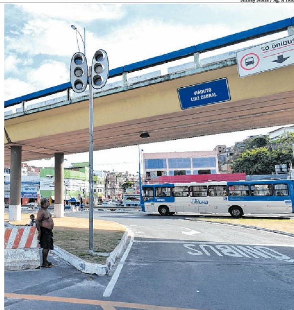
Obra entre as duas avenidas foi executada pela Sucoop e custou cerca de R$ 1 milhão
