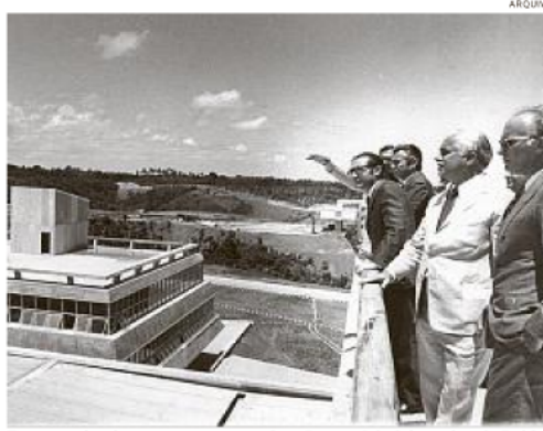
Em seu primeiro governo, construiu o Centro Administrativo da Bahia
