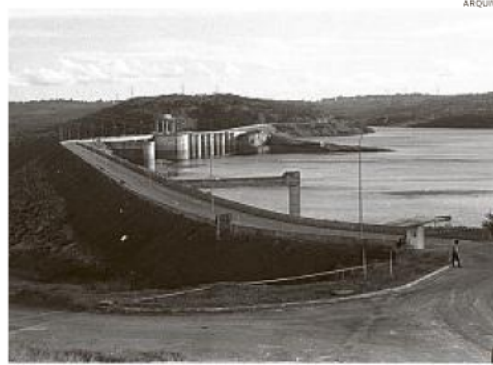
Barragem de Pedra do Cavalo foi obra do seu segundo mandato
