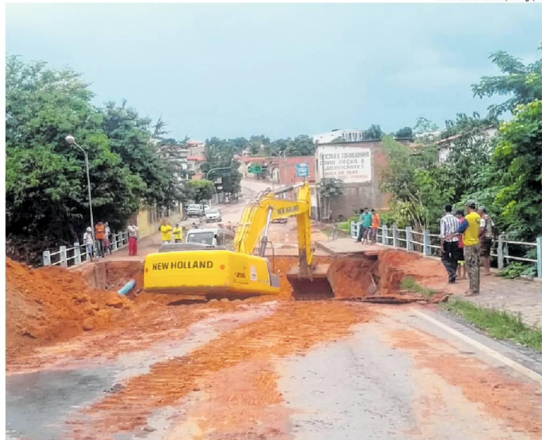
Serviço de restauração do trecho da BR 349, que está interrompido desde o dia 2 de novembro, começou ontem
