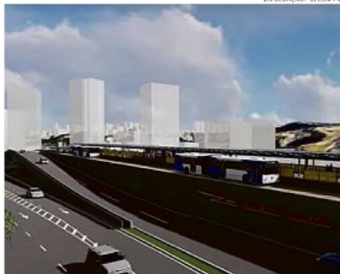
Os ônibus irão circular em duas faixas de concreto, sem semáforos
