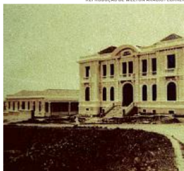
Durante a construção, local era quase desabitado
