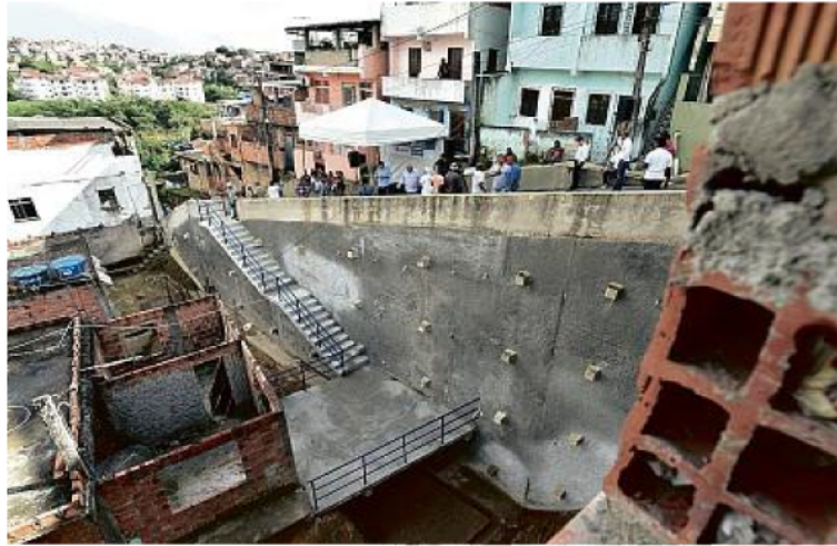
Obra durou um ano e teve investimento de R$ 1,2 milhão; outras oito obras do tipo estão em andamento
