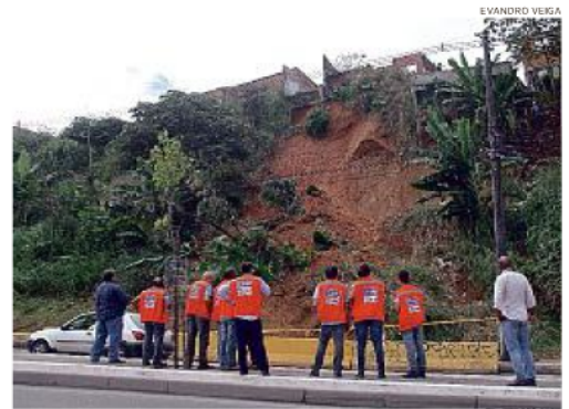
Técnicos analisavam terreno, que continuava isolado na tarde de ontem
